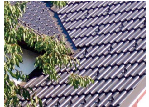
Moderne Dachdeckung - Schneehaltesystem aus Schneenasen
