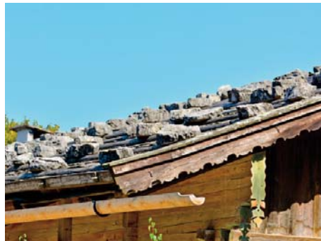
Dachdeckung mit Schindeln - Schnee- und Windschutz durch Steine
