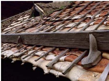
Dachdeckung mit Birkenrinde - Schneeschutzbarriere aus Holzpfosten
